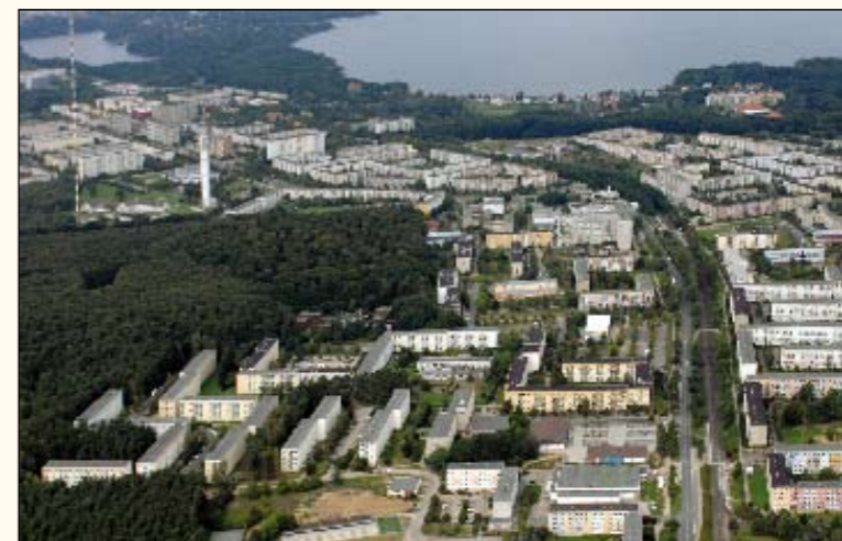
Auch auf dem Dreesch wird mit Fernwärme geheizt
