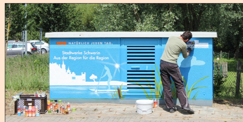
Oben: Die neugestaltete Station Ellerried weist auch den Weg zum Kundencenter Unten: Christian Pursch bei letzten Arbeiten an der Station Grabenstraße Foto: SWS/uk
