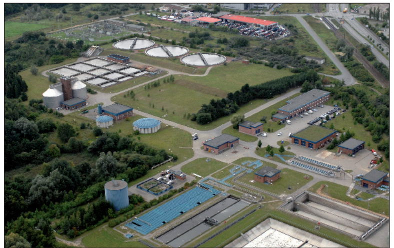
Bei einer Führung über das Gelände der Kläranlage Schwerin Süd können Interessierte mehr über die Reinigung des Schweriner Abwassers erfahren Fotos: max/cj
