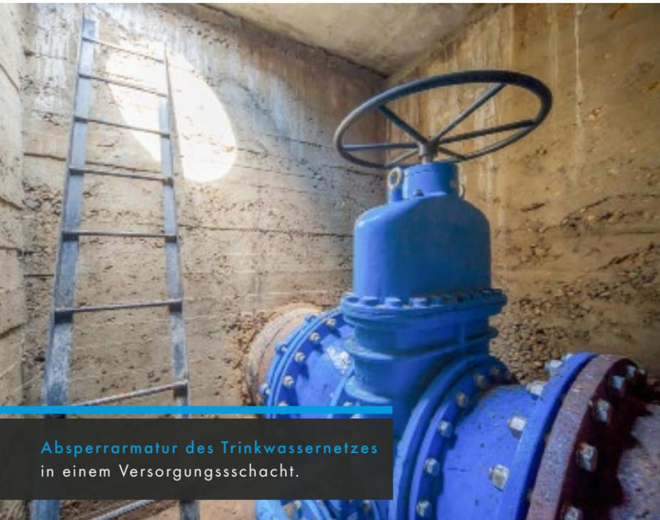
Absperrarmatur des Trinkwassernetzes in einem Versorgungsschacht.
